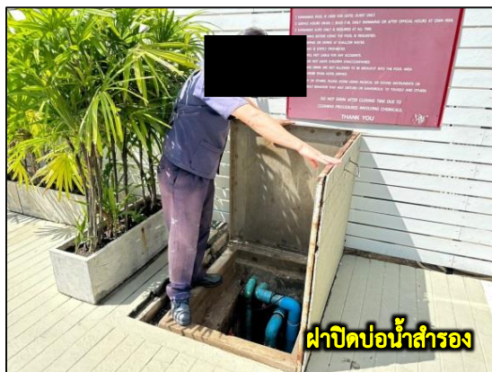
รูปที่ 3-9 บ่อเก็บน้ำใช้ ระบบกรองน้ำ และเจ้าหน้าที่คอยตรวจสอบระบบการทำงาน ภายในโครงการ
