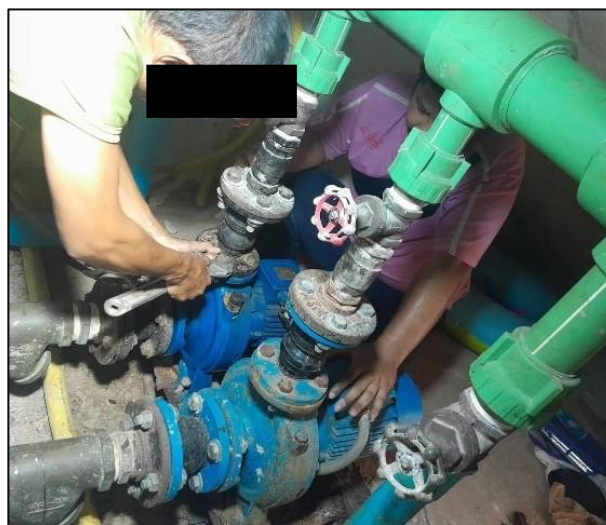
รูปที่ 3-29 เจ้าหน้าที่ตรวจสอบดูแลระบบเครื่องปั้มน้ำ
