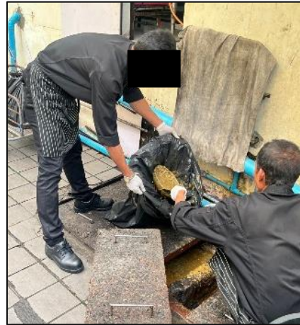
รูปที่ 3-33 เจ้าหน้าที่ขุดลอกตะกอนและทำความสะอาดท่อระบายน้ำและบ่อหน่วงน้ำภายในโครงการ
