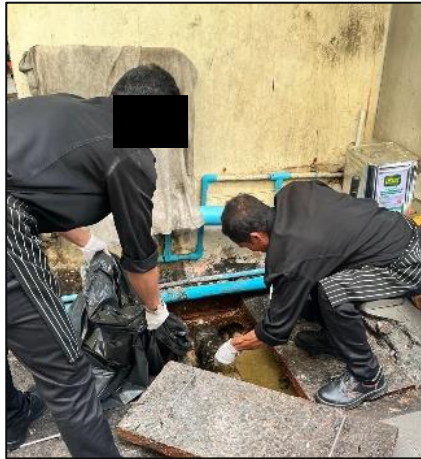
รูปที่ 3-33 เจ้าหน้าที่ขุดลอกตะกอนและทำความสะอาดท่อระบายน้ำและบ่อหน่วงน้ำภายในโครงการ
